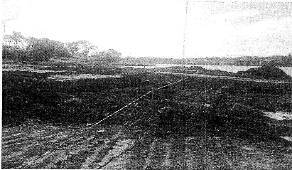
Foto 04: Trecho da Avenida Copacabana, para execução do calçamento do pavimento intertravado sextavado.
