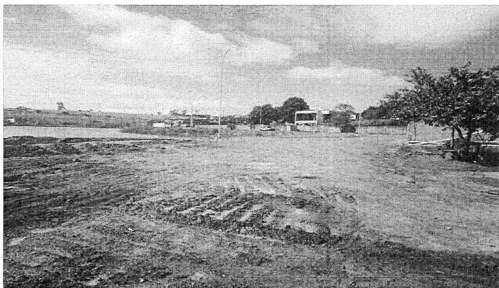
Foto 03: Trecho da Avenida Copacabana, para execução do calçamento do pavimento intertravado sextavado.
